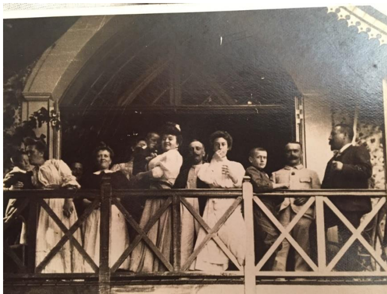
Photo 110 : Sur le balcon de la maison de Grosrouvre
