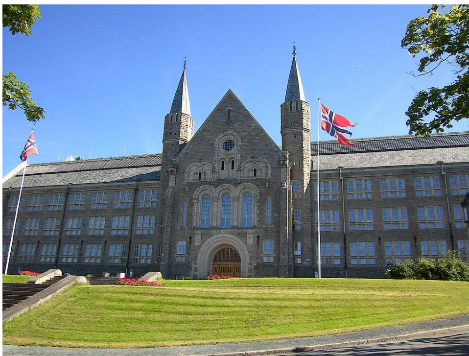
Photo 25 : Le bâtiment d'administration principale de la NTNU, situé sur le campus de Gløshaugen à Trondheim
