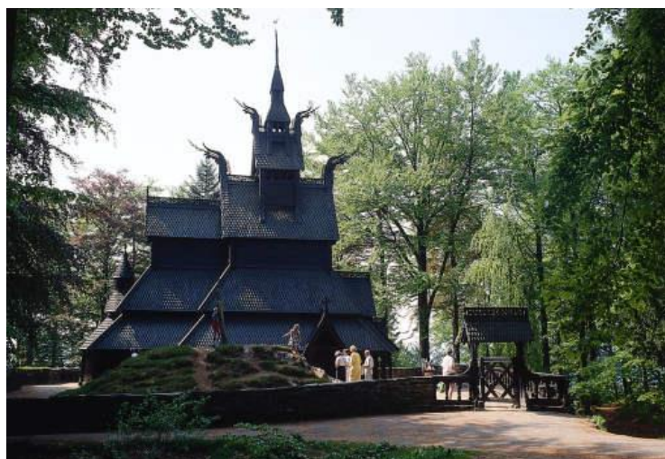
Photo 19 : L'église en bois (Stavkirke) de Fantoft
