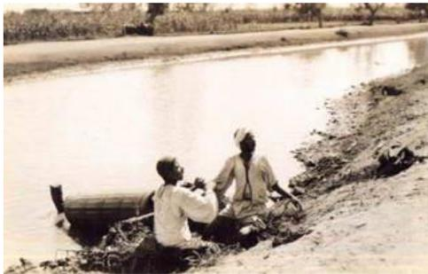
Photo 16 : Deux paysans puisant de l'eau au moyen de la vis d'Archimède en 1923
