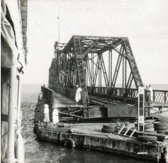
Photo 96 : Le pont tournant de Kosti construit par Cleveland Bridge UK Ltd en 1910
